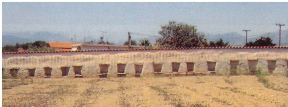
25 Τοίχος με θυρίδες για την τοποθέτηση ανάστομων κοφινιών στο Μοναστηράκι Αργολίδας (φωτ.: Θ. Μπίκος).
