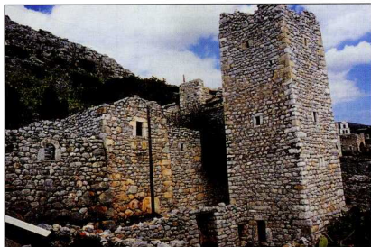
Άλκα: "Παλιομανιάτικες κατοικίες" με πύργο.
