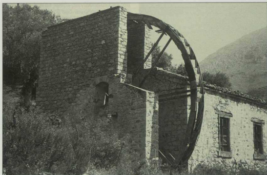
2. Σαμοθράκη, Λάκκωμα. Μεγάλη εξωτερική ορθή σφαιρική (ροδόση) υδροκίνητη λιοτριβιά, μικής κατασκευής με χρήση ξύλου και σιδήρου. Διακρίνονται τα φανώματα (κουβοδάκια) που γέρμζαν με νερό.
