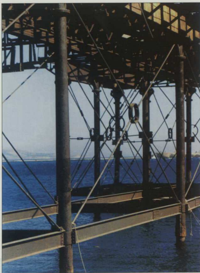
2. Λεπτομέρεια της κατασκευής της σκόλης φόρτισης μεταλλωμάτων της Γαλλικής Εταιρείας Μεταλλικών Λαυρίου. Η μεταλλική σκόλη κατασκευάστηκε το 1888. Διακρίνεται η δομή του δικτυώματος με κυλινδρικούς στύλους, δοκούς διατομής διπλού T και διαγώνια αντανάξη από ραβδούς που συνδέονται με δακτυλίους (φωτ.: Σ. Παπαδόπουλος, Β. Smith, 1998).
