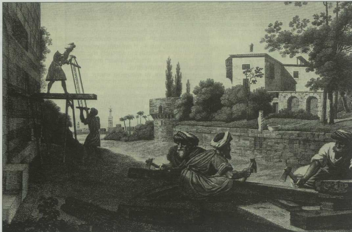
5. Σχίσμο ξυλοδοκών με «κατοράχη», πελέκωμα με σκερόνια [Πηγή: E.F. Jomard, Description de l'Égypte , Paris 1822, βλ. S. Maury - A. Raymond - J. Revault - M. Zakariya, Palais et Maisons du Caire , v. II, CNRS, Paris 1983, σ. 347].
