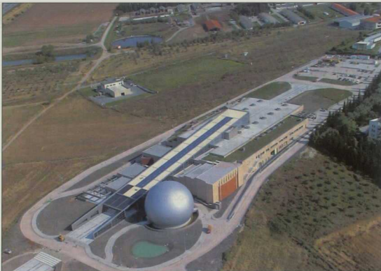
2. Οι νέες εγκαταστάσεις στην περιοχή Θέρμης Θεσσαλονίκης.
