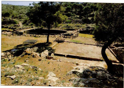
5. Πλυντήριο μεταλλεύματος και παρακείμενη υπαίθρια δεξαμενή νερού στην Αγ. Τριάδα. Αποψη από Β.
