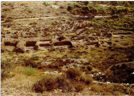
4. Παρακείμενα πλυντήρια μεταλλεύματος λαξευμένα στον βράχο της Α. όχθης της Κοιλιάδας Μπερτσίκου. Αποψη από Δ.
