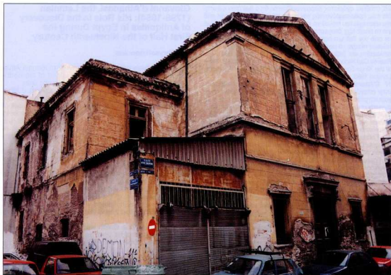
1. Το κτήριο του Παλαιού Κακουργιοδικείου στη γωνία των οδών Αγίας Ελεούσης και Κακουργιοδικείου (περιοχή Ψυρρή) πριν από την αποκατάσταση.
