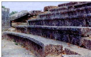
4. Ασβεστολίθους, εντυπωσιακή ανάπτυξη μικροχλωρίδας. Είναι φανερά τα σημάδια προχωρημένου σταδίου επιοχρήσης από φυτικούς οργανισμούς.
