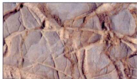
3. Ασβεστολίθους (κερκίδες), διαφορετικές απομειώσεις που οφείλονται σε ετερογένεια των λίθων.
