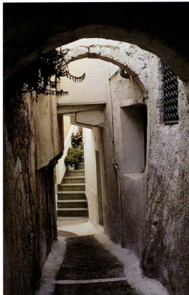
Χώρα Νάξου: Τοξυτές αντηρίδες στηρίξης απέναντι κτηρίων σε δρομίσιο.
