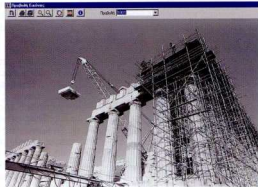
4. Θόβη εμφάνιση του συνολικού μεγέθους μιας εικόνας στη βάση—επανατοποθέτηση συντηρημένου λίθου στο νοσηνοανακτολικό γέισο του Παρθενώνα.
