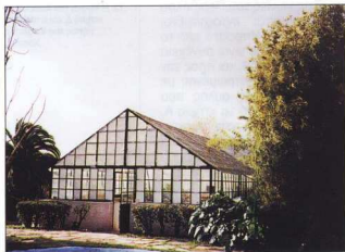
16. Το παλιό Θερμοκήπιο μετά τη συντήρησή του.
