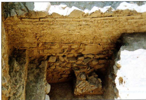
1. Ανασκαφικό τετράγωνο D1. Αποψη του περιμετρικού τοίχου του κτηρίου από τα δυτικά. Διακρίνονται λεπτομέρειες της ταξοδομίας του με τη χρήση οριζοντιών, αρχών λίθων και οριζοντιών οπίων λίθων.
