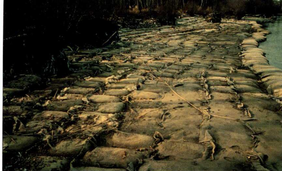
3. Η θέση Font, μετά τη λήψη των μέτρων προστασίας, σε περίοδο χαμηλής στάθμης των υδάτων.
