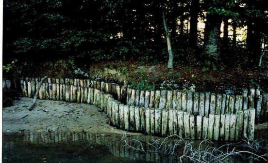
5. Τοποθέτηση φράκτη στο άκρο της όχθης, για να προστατευθούν τα αρχαιολογικά κατάλοιπα (Schiffenen).
