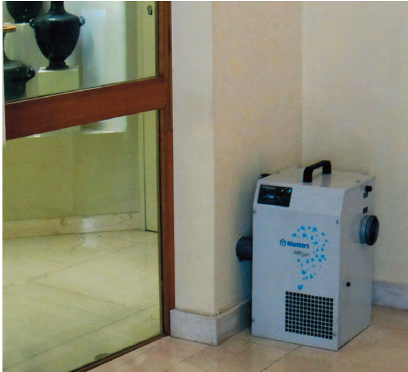
04 Μηχάνημα προσαγωγής στο χώρο ωπού αέρα (ύγρανση).
