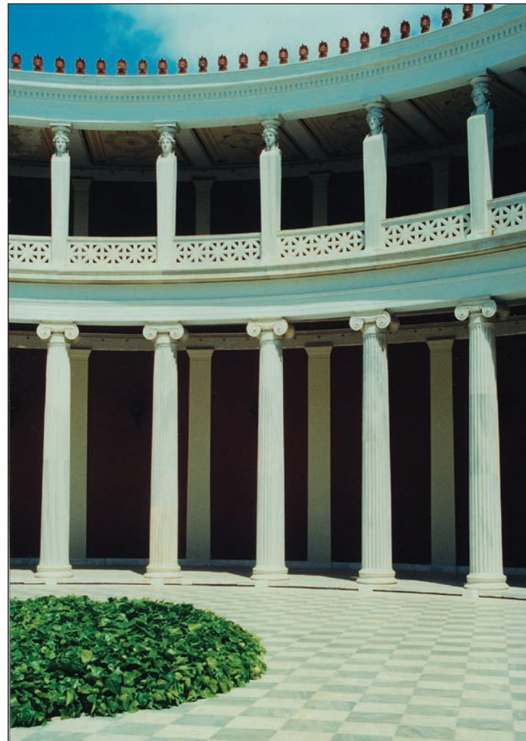
1. Το Ζάππειο Μέγαρο είναι χαρακτηριστική περίπτωση δημοσίου κτηρίου, όπου η έκταση του περιβάλλοντος χώρου περιορίστηκε λόγω της αδυναμίας του κράτους να απαλλοτριώσει τα ιδιωτικά οικόπεδα που το περιέβαλλαν.
