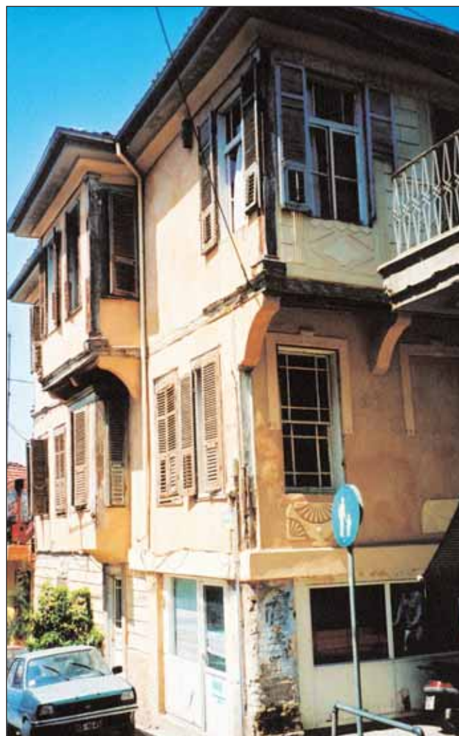
1. Άποψη του κτιρίου από την οδό Δημ. Πολιορκητού.
