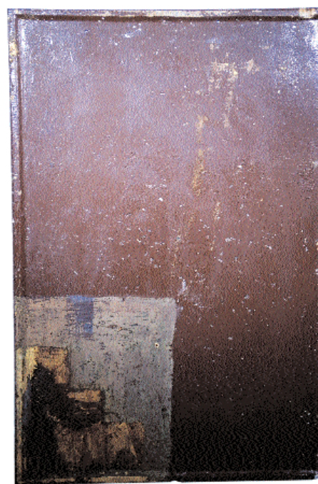
5. Η Α΄ όψη κατά τη διάρκεια της αφαίρεσης των διαδοχικών επιχρωματισμών και του καθαρισμού.
