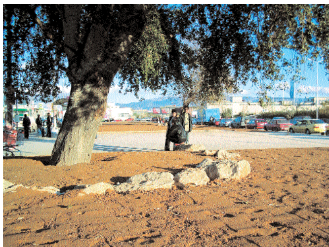
9. Έναρξη εργασιών ανάπλασης Οδού Πέτρου Ράλλη μετά την εν μέρει εφαρμογή του ρυθμιστικού σχεδίου του Ο.Ρ.Σ.Α., Π.Δ. 1049. Ανάδειξη των ιστορικών φυλών που σώθηκαν και δημιουργία οπτικής σύνδεσης με Ακρόπολη (διακρίνεται αχνά στο βάθος).
