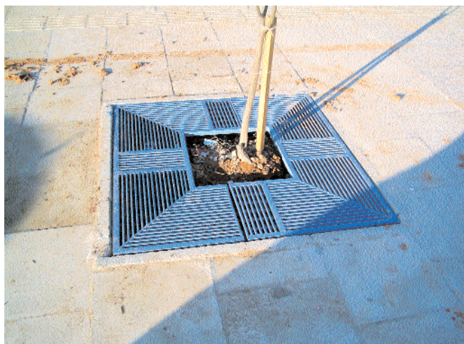
13. Μεταλλική σχάρα προστασίας δένδρων με πρότυπες διαστάσεις 1,40 x 1,40 μ. Δυναμική ανάδειξη και προστασία των νέων ελαιόδένδρων σε πλακοστρωμένες περιοχές. Το ειδικό σταυρωτό σχήμα της σχάρας επικεντρώνει το ενδιαφέρον της ανάπλασης στις φυτεύσεις, οι οποίες αποτελούν κυρίαρχο στοιχείο του σχεδιασμού.
