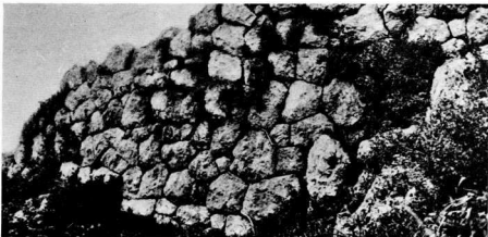
11. Α. Χαρακτηρίζει οικονομικό κτίσμα και θιαστική εργασία. Συναντάται σε πολλές περιοχές και χρονολογείται σε διάφορες εποχές (Έλευσινα, τείχος Ν.Δ. του Πλουτωνίου, αρχαϊκή περίοδος, W. Wrede, Attische Mauern, σμ. 8). Γόρτυς Άρκαδίας, τείχος τής πόλης, Α. τμήμα (4ος-5ος αι. π.Χ. BCH 1947-8, σ. 131, εικ. 23 κ.ά).
