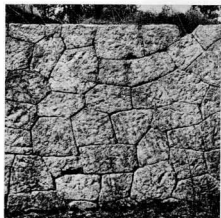
12. Α. Οι καλογραμμένοι καμπυλόσχημοι άρμοί απαιτούσαν τέχνη στην κατασκευή τους. Μόλις μία σειρά από λίθους ήταν στη θέση της (ένος δόμο) ο τεχνίτης, με τη βοήθεια μιάς μολύβδινης ταινίας έβγαζε μήτρα ώστε οι λίθοι που θα σχημάτιζαν την επόμενη σειρά (δόμο) να έχουν τέλεια έπαφη. Τό πολίτερο παρόδειγμα τέτοιας τοιχοδομίας που έχουμε μέχρι σήμερα είναι στην Έλευσινα (7ος αι. π.Χ. Πρώτο τηλεστήριο) και φτάνει ως τούς Μηδικούς πολέμους.
