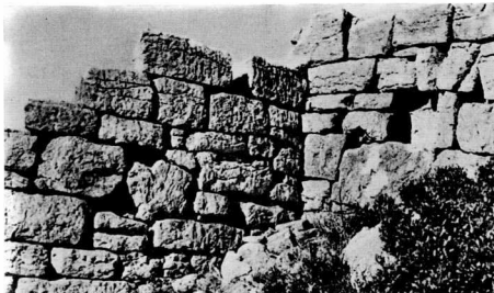
17. Γ.. Τό άκανόνιστο όρθωγώνιο σύστημα τοιχοδομίας είναι τό πύ εύκολο στην κατασκευή και συγχρόνως τό πύ οικονομικό γι' αυτό και τό συναντάμε σ' όλες τις έποχές.
