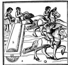
7. Τρεῖς τρόποι μεταφοράς βαριών λίθων και κίονων σύμφωνα με τὸ Βιτρούβιο (Vitruve, Cl. Perrault, 1673, Paris 1967).
