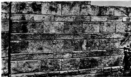
18. Γ.. Τό όρθωγώνιο ψευδοϊσοδομο σύστημα. Σύστημα τοιχοδομίας με μεγάλη διάδοση στό χώρο και στό χρόνο, είναι από τό πύ διακοσμητικά.
