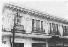
14. Αξιόλογο κτίσμα στην οδό Βασιλείου - Βλησάρη - Συγγρού.
