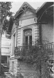
29. Τμήμα της προσόψεως του κτιρίου της Θ. Σοφούλης 6 (κατεδιορίστηκε).
