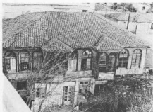
6. Διατηρητέο κτίριο που καταδοφίστηκε στην πλατεία Τερψιθέας και παρόδο Ήσιουδου 4.
