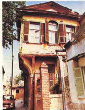
5. Διατηρητέο κτίριο στην οδό 'Αθηνά 44.
