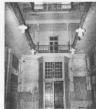
19. Λεπτομέρειες από το εσωτερικό του κτιρίου στην Τσακάλη 22.
