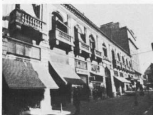
11. Διατηρητέο κτίριο στοάς Σαούλ. Οψη προς την οδό Βασ. Ηρακλείου.
