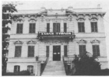
31. Το διατηρητέο κτίριο της σχολής Τυφλών.
