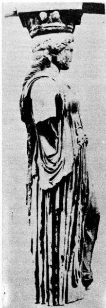
3. Καρυάτις. Παρατηρούμε δύο τύπους φθοράς: στο δεξί μέρος, που έρχεται σε έπαφή με τά νερά της βροχής, όδην προσβολή, στο άριστερό μέρος που δέν έρχεται, θείωση.
