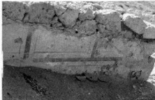
7. Λεπτομέρεια από τη διακόσμηση του εξωτερικού οσβά. Εξαιρετική είναι η διατήρηση των εξωτερικών επιχρισμάτων τα οποία φαίνεται ότι οι κάτοικοι του άλλαξαν τουλάχιστον δύο φορές.
