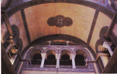
12. Δυτικό τόξο κεντρικού σταυρικού πυρήνα μετά την αποκατάσταση.
