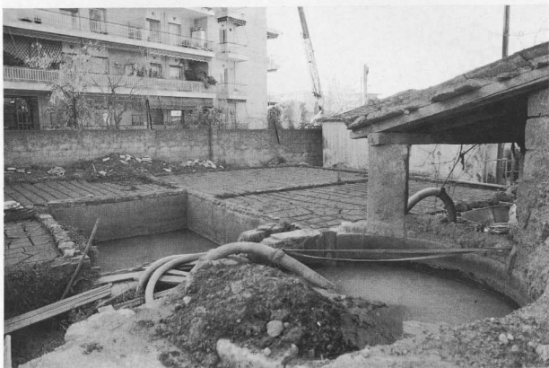
6. Η κυλινδρική «καρούτα», μέσα στην οποία γίνεται το ανακάτεμα του ηπλοχώματος με το νερό.
