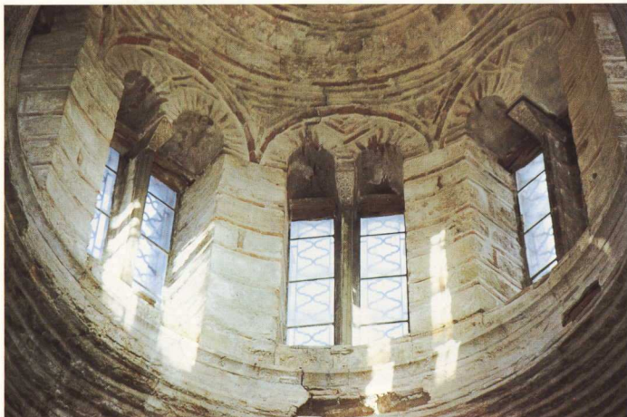
18. Το εσωτερικό του τρούλλου της Παναγίας. Το τύμπανο είναι χτισμένο με ορθογωνισμένους πυρολιθούς.
