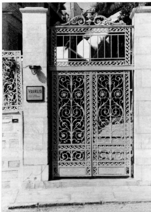
2. Η δυτική εξώπορτα μετά τις εργασίες καθαρισμού (με αμμοβολή).
