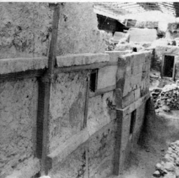
22. Βόρεια όψη Ξεστής 2: σζώνται δύο όροφοί πάνω από τό ισόγειο. 'Ορίζόντιες και κατακόρυφες έμβολοειδείς ένισχύον τό τόχο (στη θέση των εύλων υπάρχει σήμερα όπλισμένο σκυρόδεμα, όστε νά έξασφαλίξεται ή στερέωση του κτιρίου). Οι όρίζόντιες, προέξουσες ταινίες από λαξευτούς πυλώλους «προβάλλουν» προς τά έξω τά δάπεδα των όρόφων.
