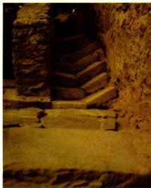
14. Κλιμακοστάσιο στην Βόρεια είσοδο του τόμου Δ.
