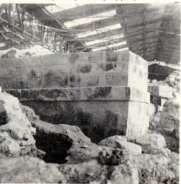
5. Νοτιοδυτικὴ γωνία Ξεστής 4 με ἐπένδυση ἀπὸ λαξευτοὺς λευκοὺς τόφφους.
