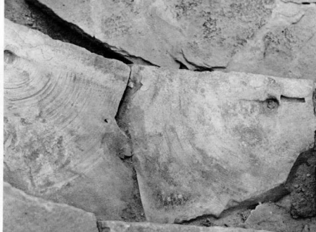
16. Κλιμακοστάσιο βόρειας εισόδου Τομέα Δ. Στο πρώτο σκαλί άνάδο προς τόν όροφο υπήρχε δι-φυλλή πόρτα, που ρυθμίζε τήν επικοινωνία μέ τούς άνω όρόφους. Τα λαξεύματα και οι χαραξίες πάνω στό μονολιθικό σκαλοπάτι δείχνουν τήν περιστροφή τών φύλλων.
