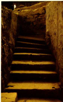
13. Κλιμακοστάσιο Ξεστής 3: πρώτο σκέλος ανέλθου προς τόν όροφο.
