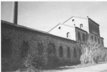
1, 2. Εξωτερική όψη του οινοποιείου «Αρέβουσα». Τα χαρακτηριστικά στοιχεία της βιομηχανικής αρχιτεκτονικής συνδυάζονται με άλλα, ιδιαίτερα προσεγμένα, πρόσθετα διακοσμητικά στοιχεία (γλάστρες, ακροκεραμα, διπλή οδοντωτή ταινία κάτω από τη στέγη). Η λιθοδομή είναι επίσης πολύ προσεγμένη.
