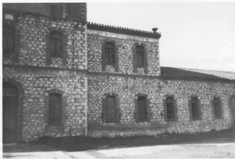
1, 2. Εξωτερική όψη του οινοποιείου «Αρέβουσα». Τα χαρακτηριστικά στοιχεία της βιομηχανικής αρχιτεκτονικής συνδυάζονται με άλλα, ιδιαίτερα προσεγμένα, πρόσθετα διακοσμητικά στοιχεία (γλάστρες, ακροκεραμα, διπλή οδοντωτή ταινία κάτω από τη στέγη). Η λιθοδομή είναι επίσης πολύ προσεγμένη.
