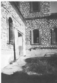
1, 2. Εξωτερική όψη του οινοποιείου «Αρέβουσα». Τα χαρακτηριστικά στοιχεία της βιομηχανικής αρχιτεκτονικής συνδυάζονται με άλλα, ιδιαίτερα προσεγμένα, πρόσθετα διακοσμητικά στοιχεία (γλάστρες, ακροκεραμα, διπλή οδοντωτή ταινία κάτω από τη στέγη). Η λιθοδομή είναι επίσης πολύ προσεγμένη.
