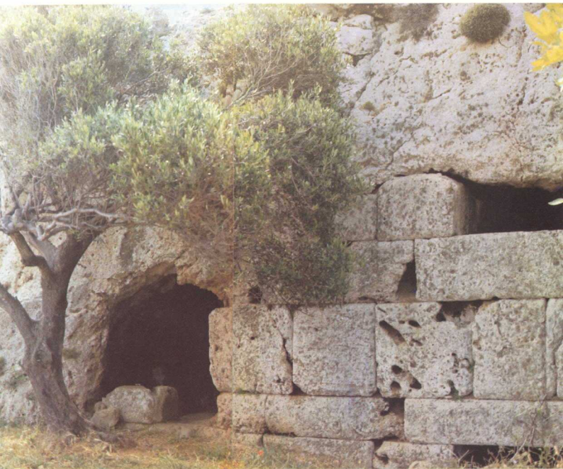
6. Μνημειακή κατασκευή της είσοδου. 7. Δείγμα τοιχοδομής έξωτερικού τοίχου.
